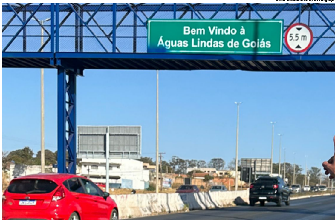
O BRT de Águas Lindas de Goiás pretende atender cerca de 50 mil pessoas, oferecendo um sistema de transporte coletivo rápido, eficiente e de alta capacidade
